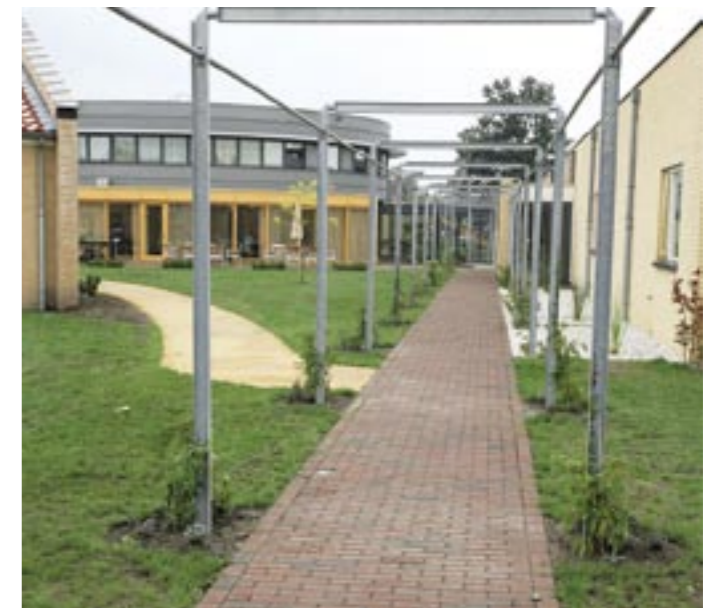
Boven het pad naar het ontmoetingsplein bij de bestaande bebouwing is een pergola aangebracht. De pergola moet nog begroeien en dient dan als schaduwplek.
