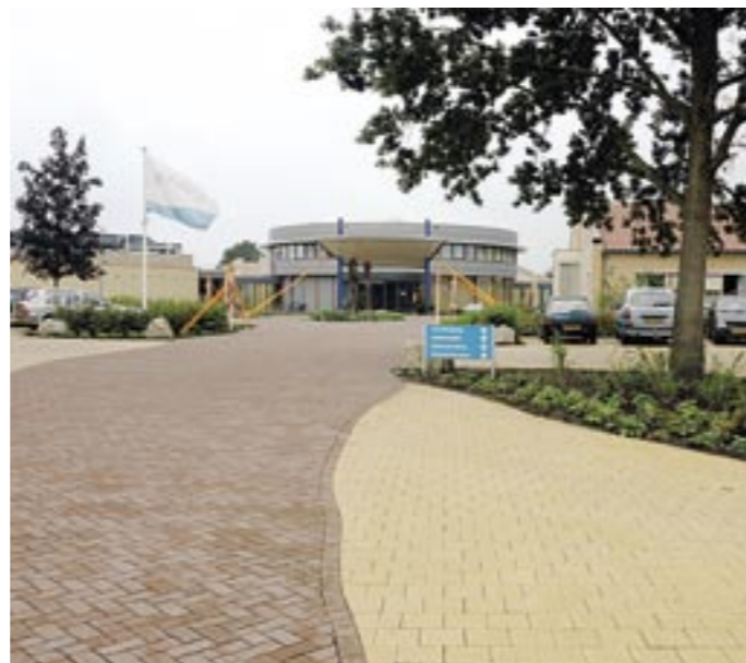
De bestrating van gebakken, rode klinkers en gele, waterdoorlatende ecostenen van Klostermann is aangelegd in golvende lijnen. Bomen, hagen en organisch gevormde plantvakken op hoogte onttrekken de geparkeerde auto's aan het zicht. De parkeerplaats oogt vriendelijk en is een ontmoetingsplek voor bezoekers.
