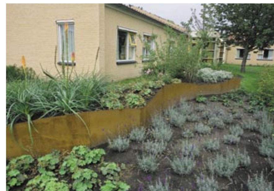
De grondkering van cortenstaal brengt het plantvak op hoogte. Bewoners hebben zo vanuit hun stoel goed zicht op de beplanting.
