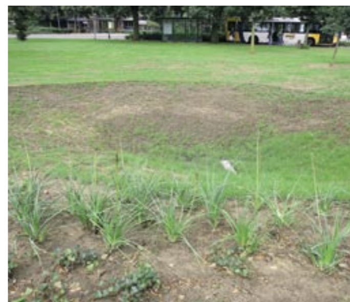
Wadi's, infiltratievelden met een ondergrond van zand en grind, zorgen voor de opvang en afvoer van regenwater.
