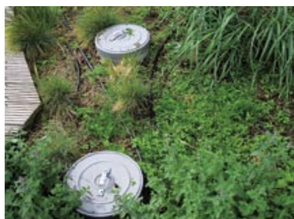
Voor de afvoer van hemelwater is het Pluvia-systeem toegepast. Dit systeem is eigenlijk niet goed toepasbaar op daken, meent Tolk. Een daktuin kan veel water bufferen: 95% wordt opgenomen door de beplanting en het substraat, 5% moet worden afgevoerd. De druppelinstallatie is slechts aangelegd voor periodes van extreme droogte.
