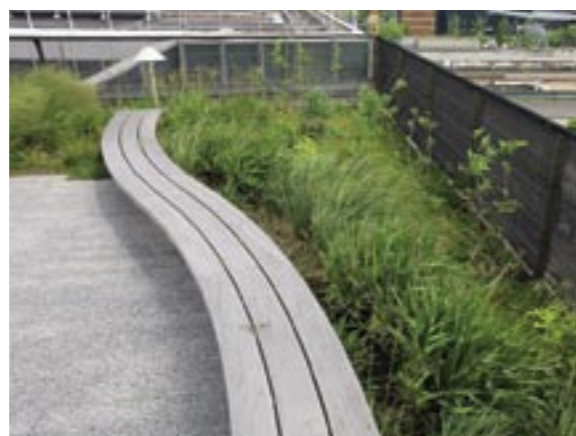
Rondom de tuin op de zesde verdieping is schermdoek aangebracht dat de beplanting beschutting biedt.
