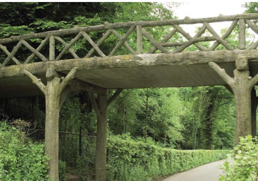
Brug van Henri Copijn op landgoed De Haar in Haarzuilens. De brug was oorspronkelijk gemaakt met cementrustiek, hout nagebootst in cement. Bij de restauratie is dit verloren gegaan.
