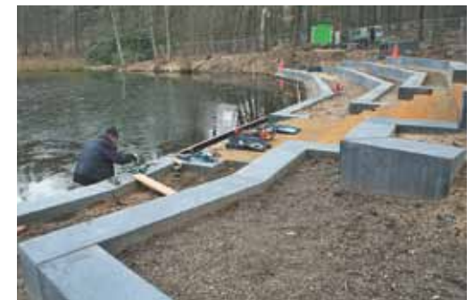
De trappenpartij aan de kop van de vijver is uitgevoerd in cortenstaal en beton. De trappen bieden in een rechte lijn zicht op de waterval aan de overkant van de vijver. „De wildgroei langs het pad rond de vijver is verwijderd, waardoor de vijver een echte eyecatcher is geworden.“
